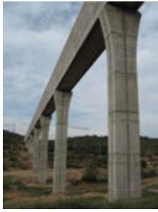
Dirección de obra
